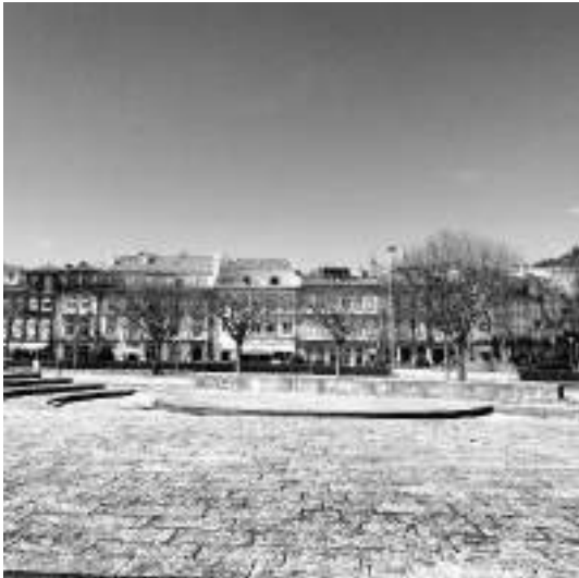
Aspeto das fachadas da rua João Alves Cerqueira
