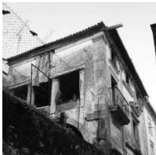
Rua dos Caleiros
