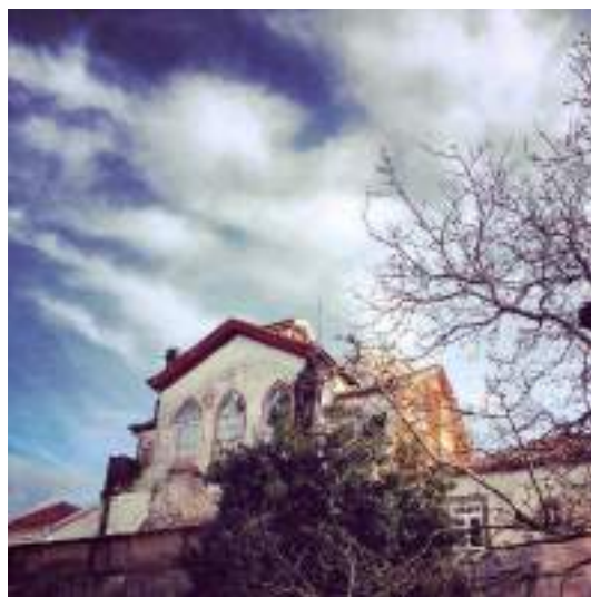
Fachada de tardo de edifício localizado na praça Frei Gonçalo Velho
